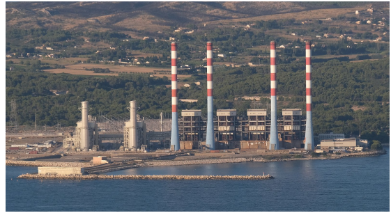
Exemple de la centrale à gaz de Martigues, France. Puissance totale de 930 MW.
